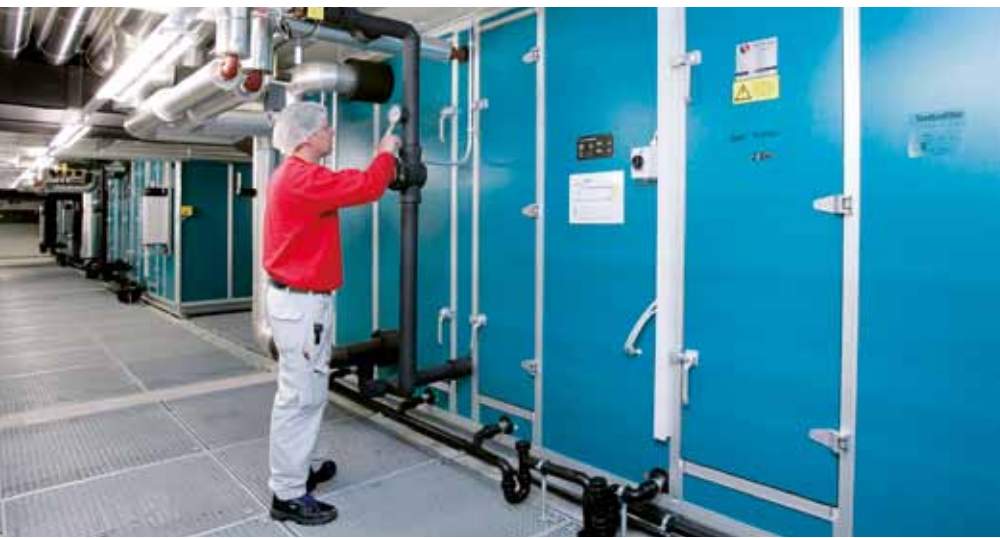
Leistungsfähig und resistent: die Frigo-Monoblocs mit GFK-Spezialbeschichtung.
