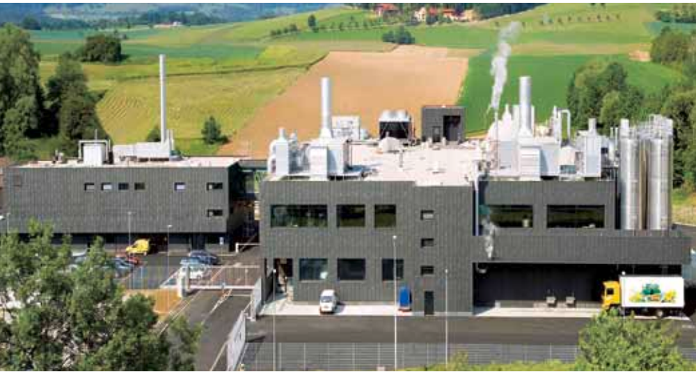
Hier wird's erfunden: die neue Kräuterbonbonfabrik von Ricola.
