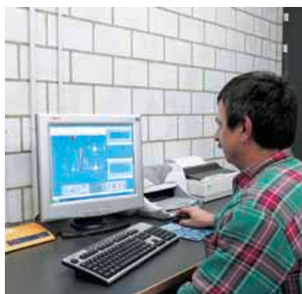
Alles auf einen Blick: Steuer- und Regelungstechnik im Gebäudeleitsystem.
