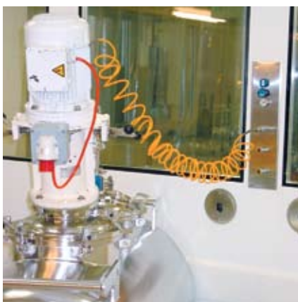
Tankanschluss vom Ansatzraum zum Abfüllraum.
