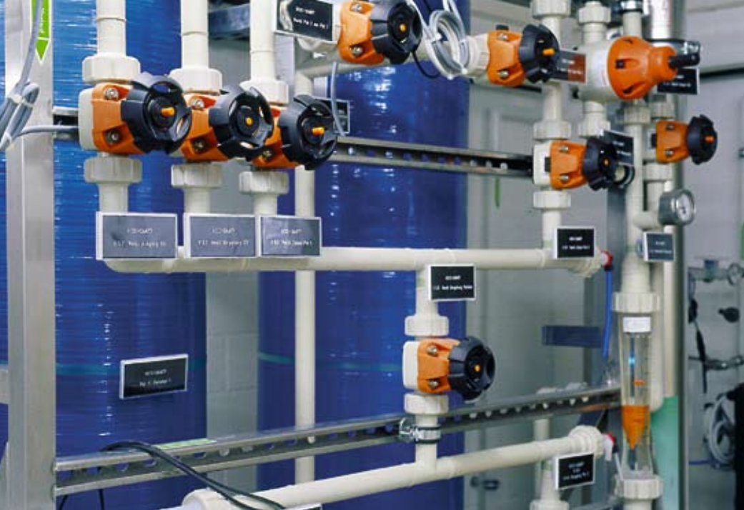
Teilansicht Reinstwasseraufbereitung
