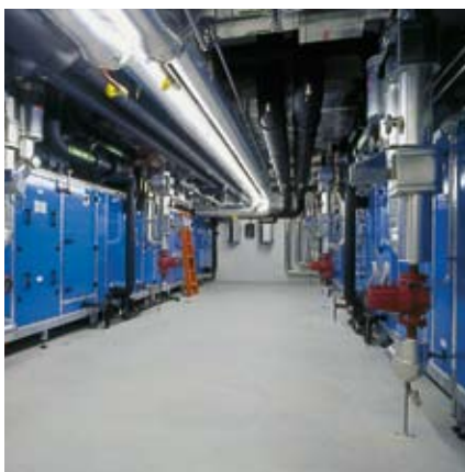
Klima-Primärluft-Aufbereitung
