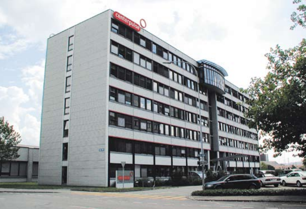
Vue du bâtiment administratif.
