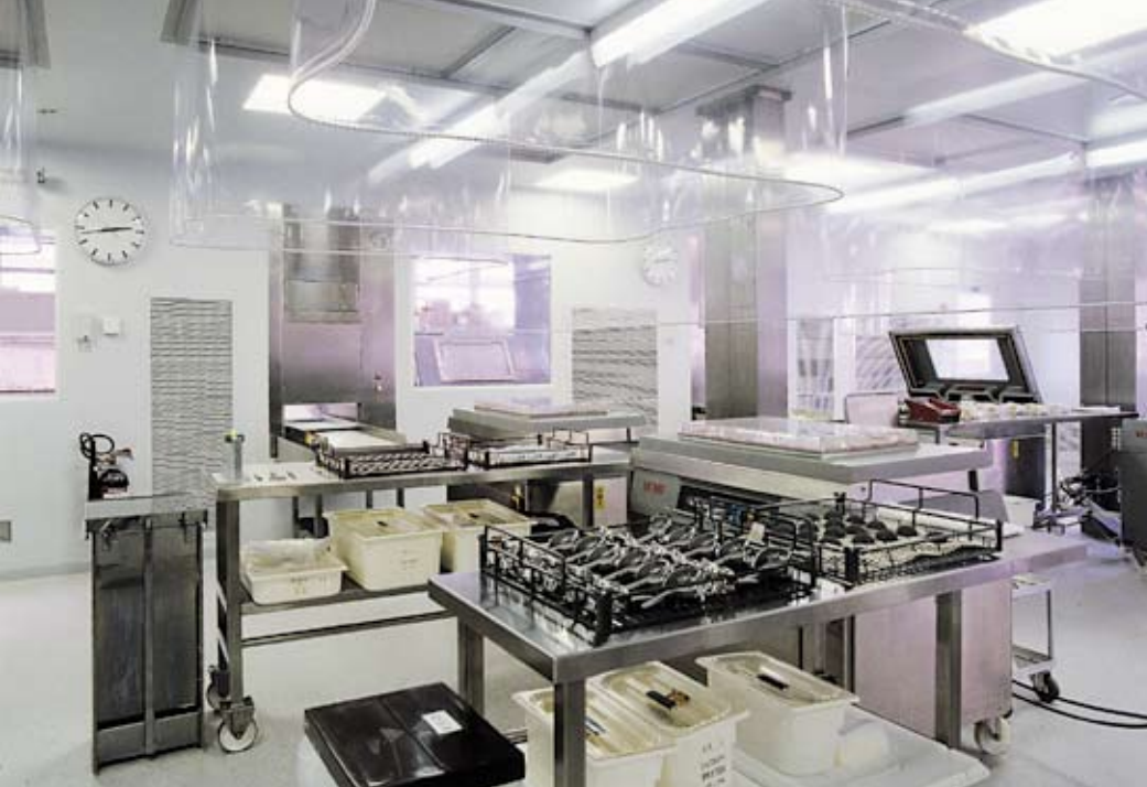
Arbeitszone ohne Personen der Reinraumklasse ISO 5. Die Hüftgelenke sind zum Verpacken bereit. Über dem Tisch befinden sich die endständigen HEPA-Filter mit Plastikvorhang zur Abgrenzung des parallelgerichteten Luftstroms. Das Luftabsauggitter ist im Hintergrund an der Wand sichtbar.
