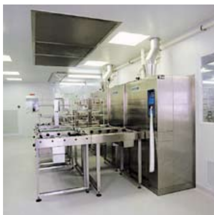
Einschleusung der Fertigprodukte und Washvorrichtung. Eine Filterdecke über- deckt die Entnahmesseite.
