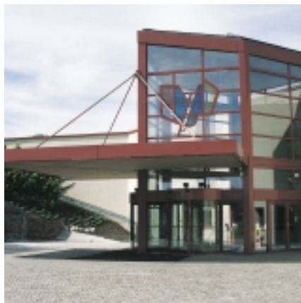
Haupteingang des Centre de Recherches der Nestlé AG. Axima sorgt hier für die ständige Verfügbarkeit der Anlagen.
