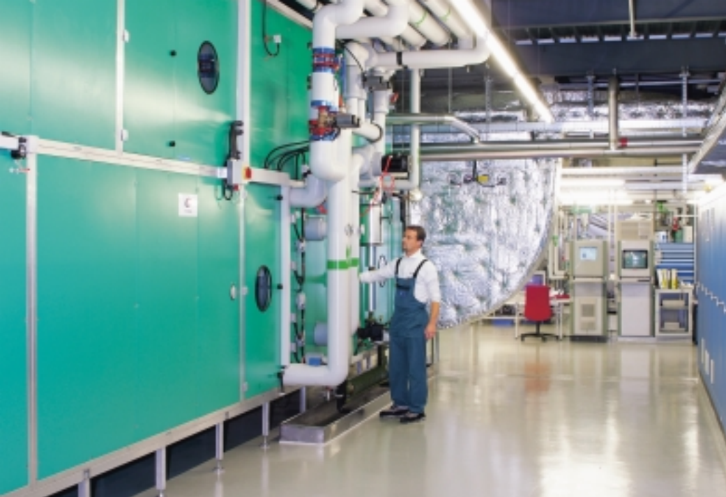
Unité de traitement d'air extérieur (Monobloc).
