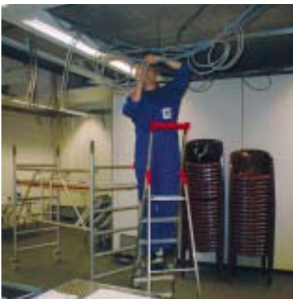
Anschluss der Kühldeckenelemente.
